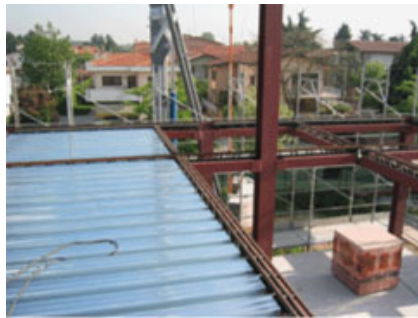
Fig. 7 – Particolare di posa del solaio di lamiera grecata.
