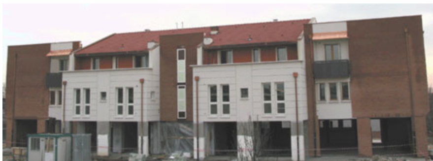
Fig. 1 – Vista generale del fabbricato.
