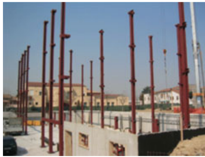
Fig. 5 – Posa dei pilastri in acciaio.
