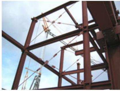
Fig. 10 – Particolare della croce in acciaio per la controventatura del vano scale.
